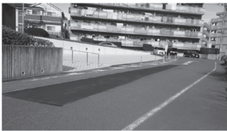
フェアヒルズ前Y字路の道路補修
