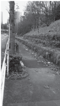
長久保交差点から上柚木競技場へ 向かう歩道の補修
