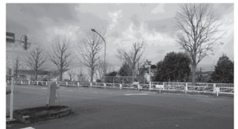
鹿島T字路（大塚橋付近）のカーブ ミラー付け替え及び角度調整
