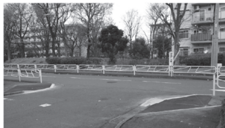
鹿島商店街入口の歩道の段差解消
